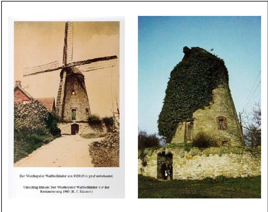
Abbildung 1: Mühle einst und jetzt
